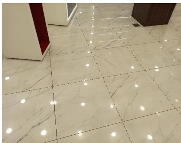
Фотография 29. Фрагменты внутренних помещений
