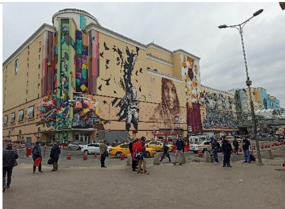
Фотография 3.1. Внешний вид здания
