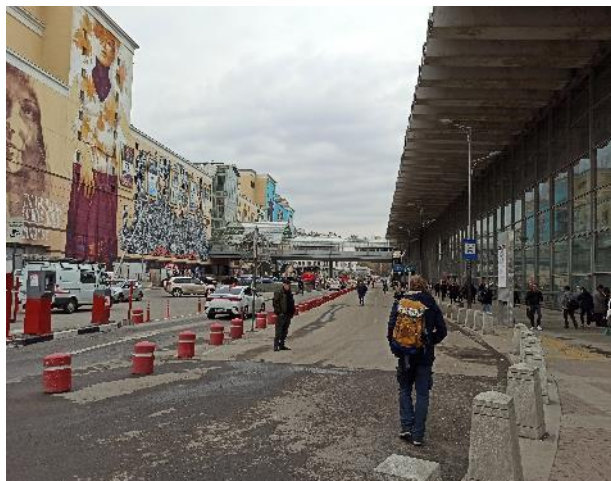
Фотография 7. Фасад здания, в котором расположен оцениваемый объект
