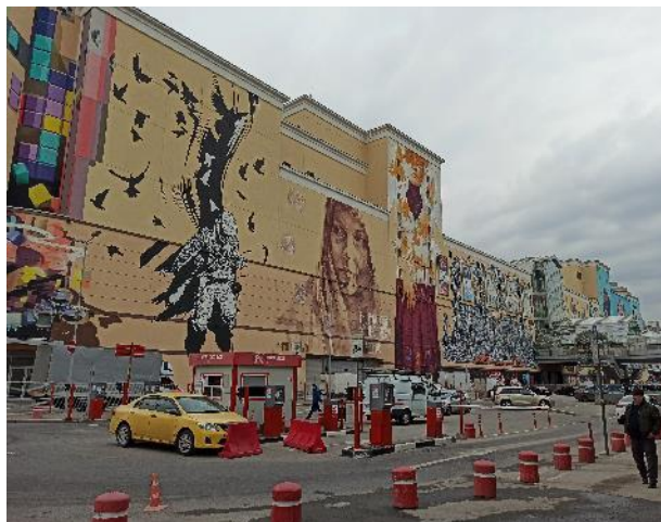
Фотография 8. Фасад здания, в котором расположен оцениваемый объект
