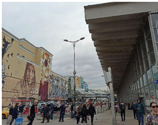
Фотография 2. Фасад здания, в котором расположен оцениваемый объект
