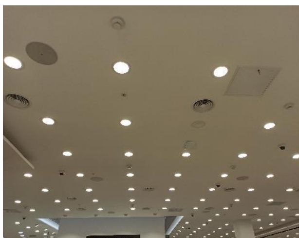
Фотография 41. Фрагменты внутренних помещений
