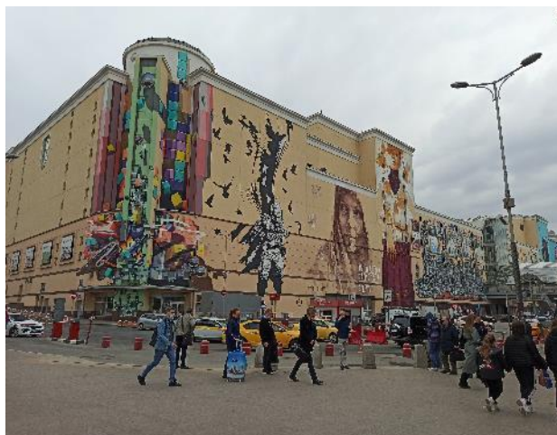
Фотография 1. Фасад здания, в котором расположен оцениваемый объект
