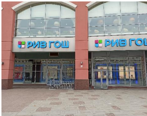
Фотография 19. Фасад здания, в котором расположен оцениваемый объект
