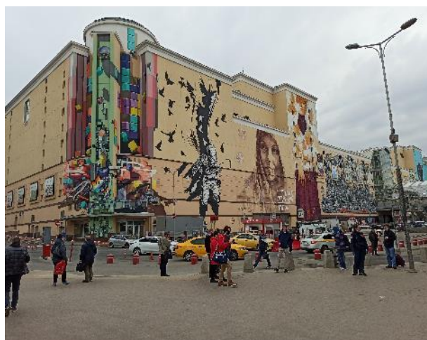
Фотография 6. Фасад здания, в котором расположен оцениваемый объект
