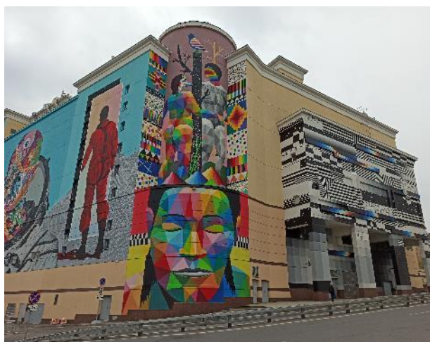
Фотография 9. Фасад здания, в котором расположен оцениваемый объект
